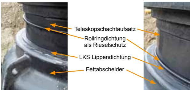
Teleskopschachtaufbau in Behälteröffnung einschieben
