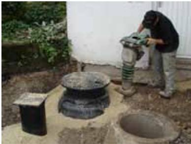
11.) ...Grube Verfüllen und Verdichten
