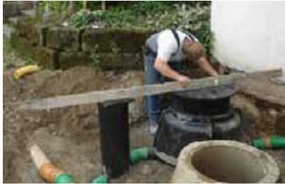
9.) Ausrichten und Abscheideranlage vor dem Befüllen auf Dichtigkeit überprüfen
